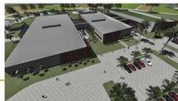
As coberturas tem funções de coleta de água, de local para fixação das placas fotovoltaicas e telhados verde, assim proporcionando um ambiente sustentável e com conforto
