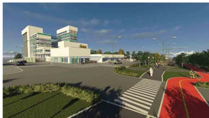
VISUAL DO CONJUNTO A PARTIR DO CANTEIRO
