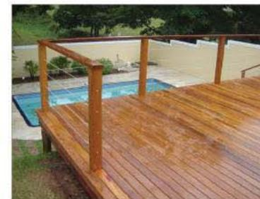
Será utilizado madeira tratada de eucalipto em todos os decks e guarda corpos construídos no conjunto.
