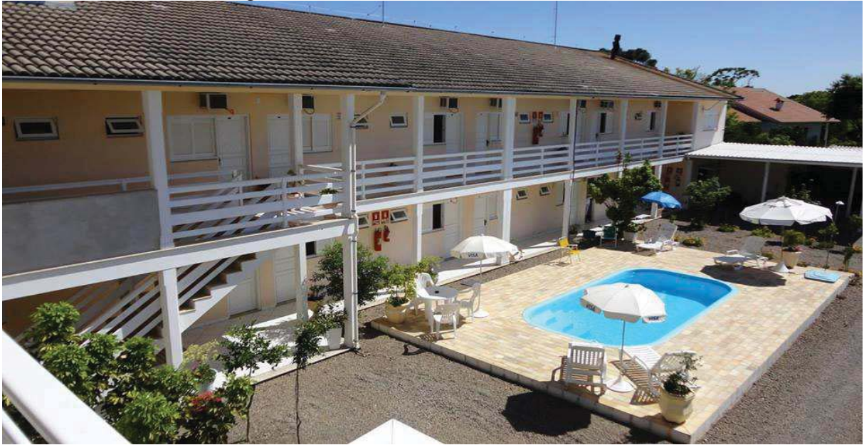
Figura 04 – Vista interna do Bei Monti Hotel
