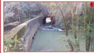
Túnel para desvio do curso da água do rio Sarandi
