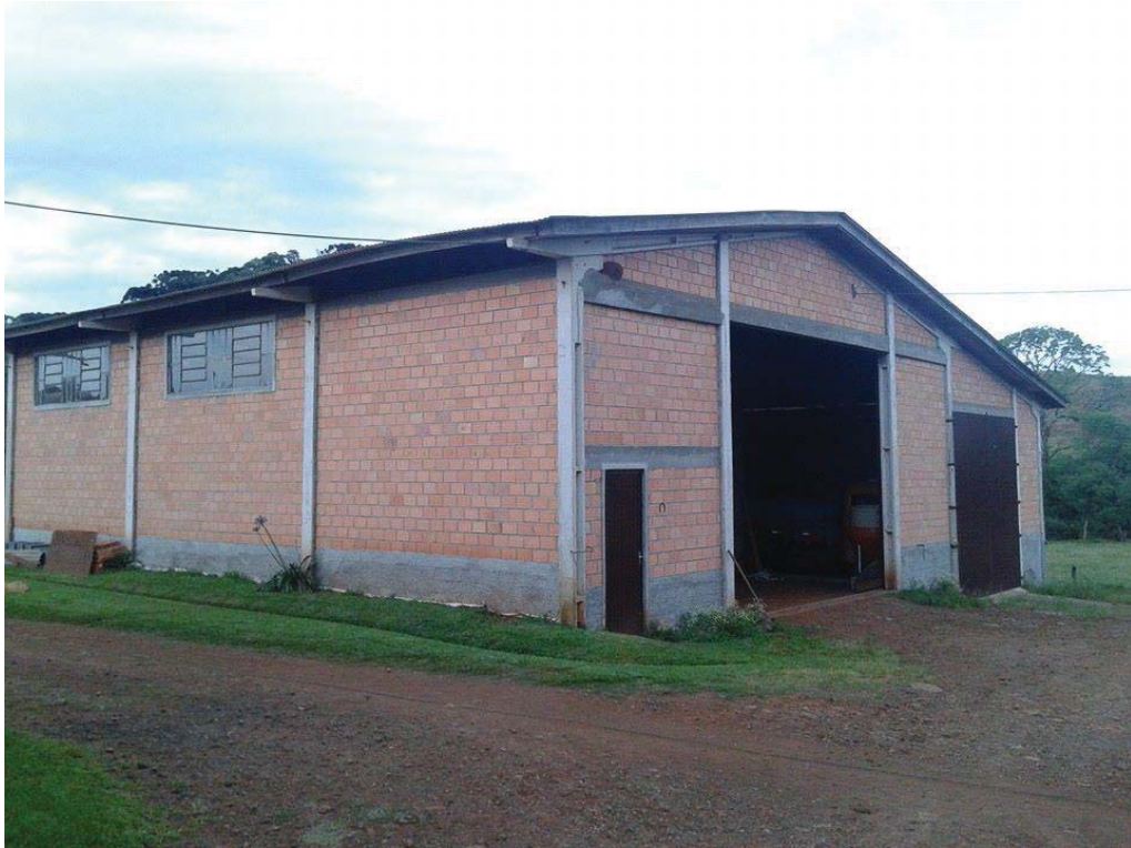
Figura 12 - Galpão construído na unidade em 2005, para guardar as máquinas, implementos e insumos. Fonte: Dados de Pesquisa da Autora, 2015.
