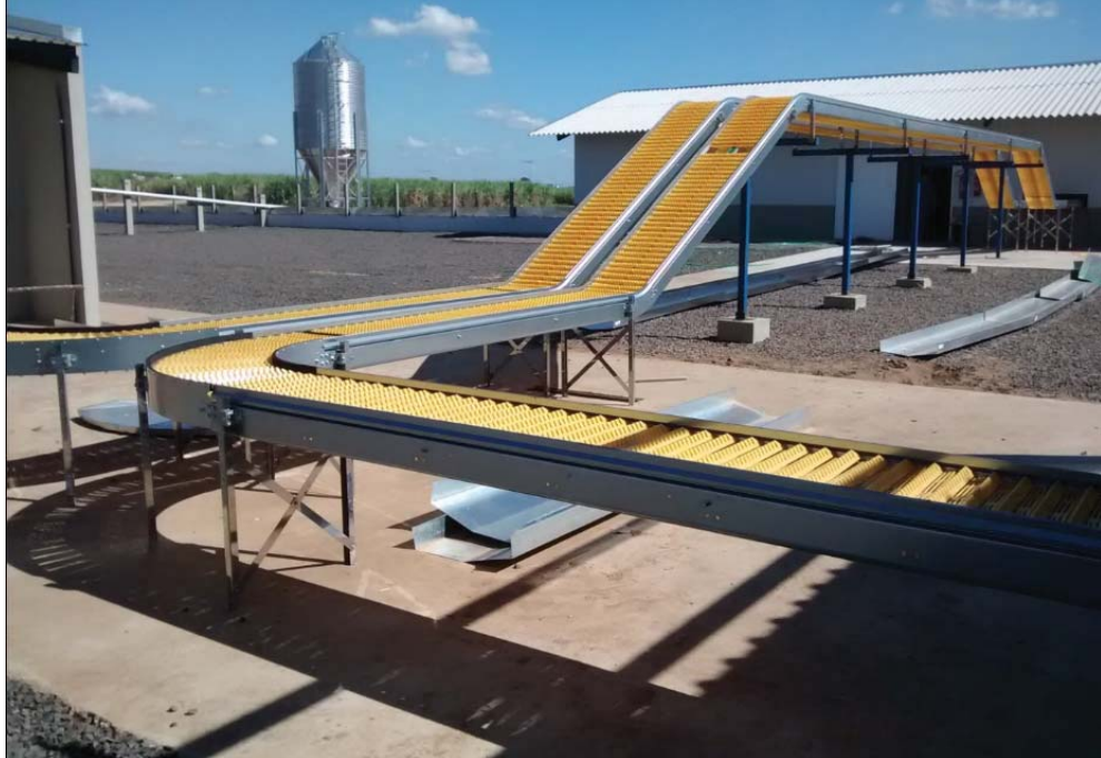
Figura 5 – Esteira transportadora de ovos em construção.
