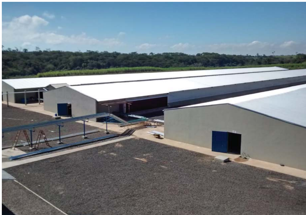
Figura 1 – Granja de produção de ovos férteis em construção.
