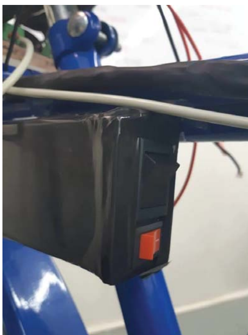
Figura 59- Chaves para desconectar baterias do sistema.
