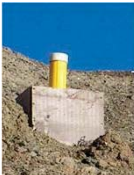
Figura 7. Vista de um tubo guia em uma obra de aterro
