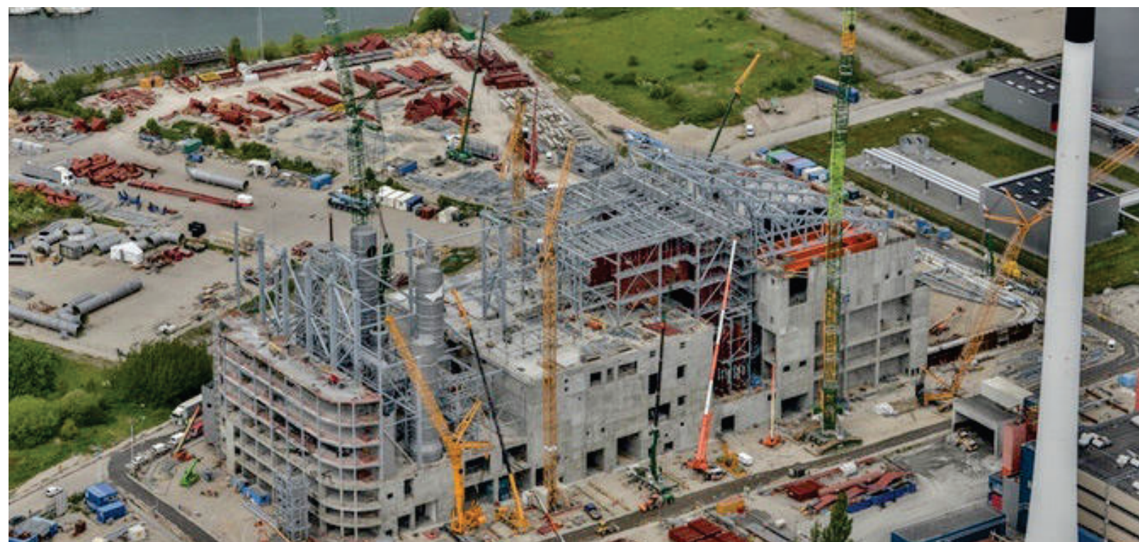
▲ Vista da casca do projeto para a cobertura sendo executada. Fonte: ARCHDAILY, 2013.
