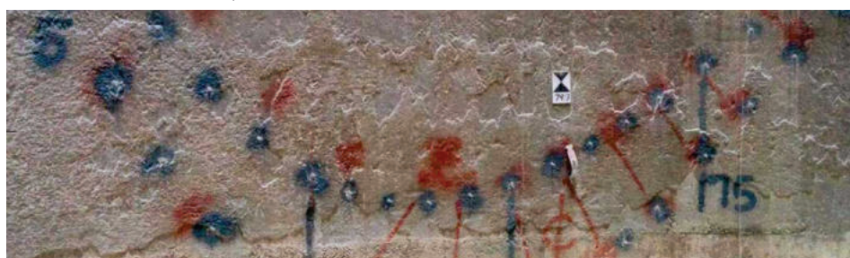
▲ Marcação para corte na execução da galeria central. Fonte: HEATHERWICK, 2019.
