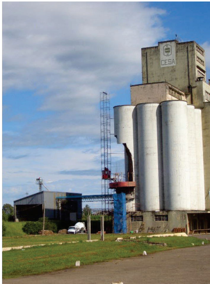
▲ Recuperação da célula do Silo que rompeu. ALCIR, 2006.
