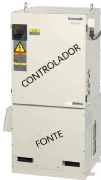
Figura 18 - Caixa de comando controlador e fonte.
