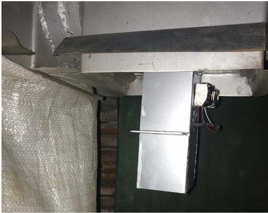
Figura 4. Caçamba e microcontrolador instalados.
