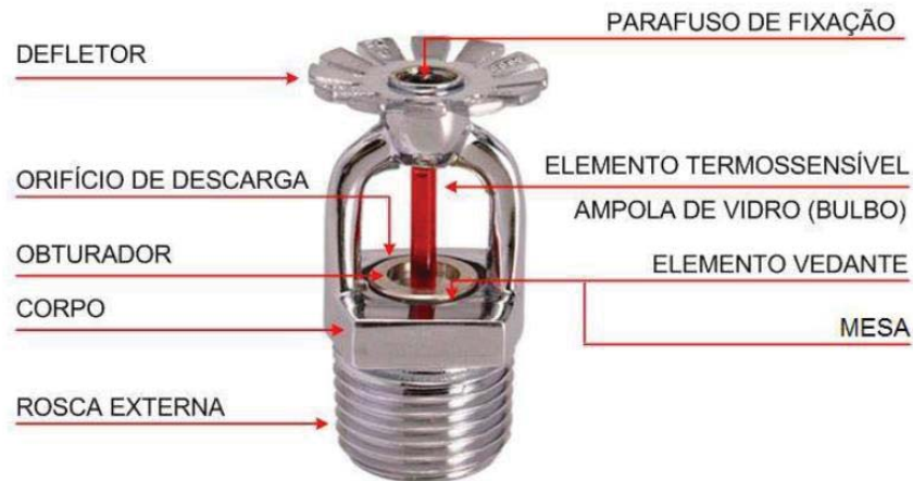
Figura 1 – Componentes de um chuveiro automático.
