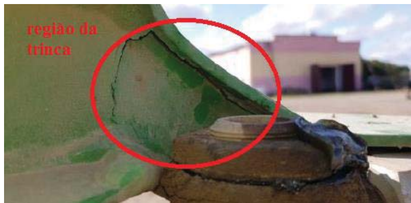
Figura 15 - Trincas no articulador principal
