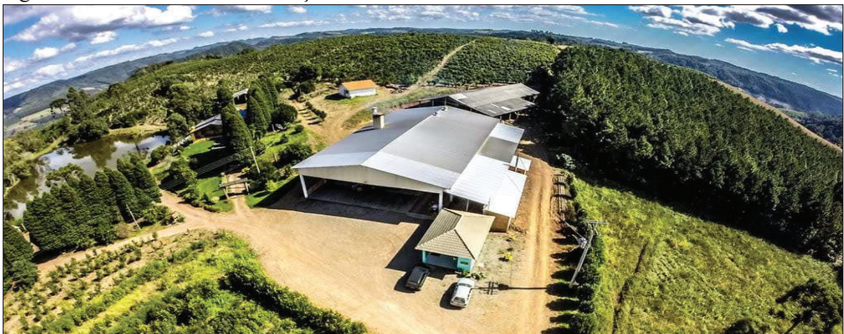
Figura 4 – Vista aérea das instalações da Ervateira.
