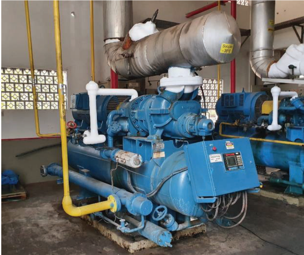
Figura 16 – Compressor de Parafuso de Amônia Mycom N250 VMD Antes da Instalação. Fonte: (Autor 2022)
