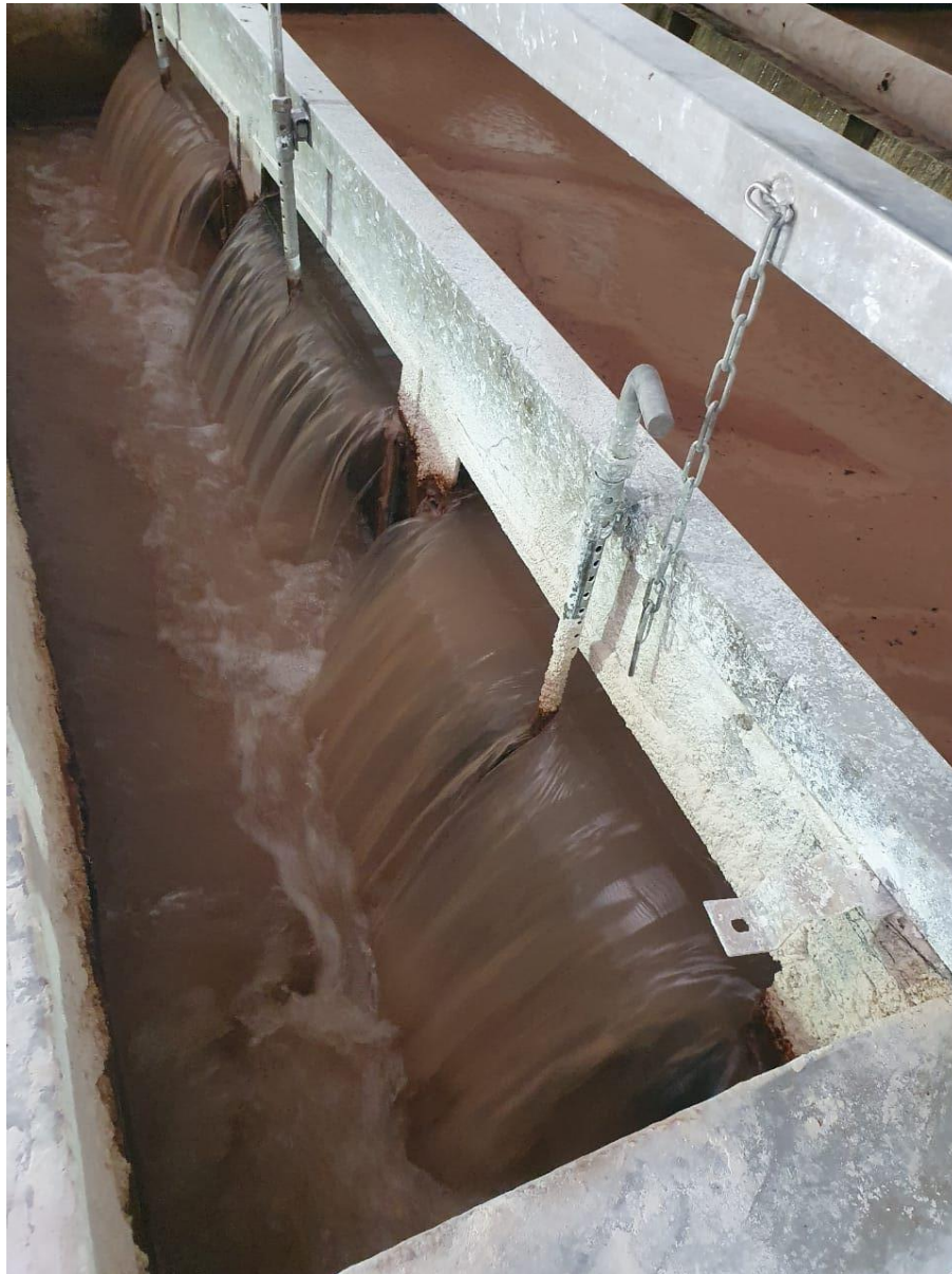
Figura 23. Efluente sem qualidade de tratamento nos flotadores em função de falha na bomba
