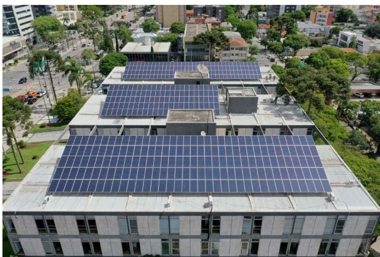
Figura 24- Prédio da Prefeitura de Curitiba.
