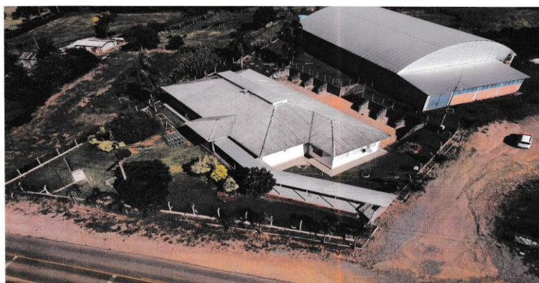
Figura 32- Escola Laurentino Machado
