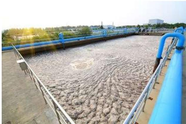
Figura 1: Sistema de armazenamento de lodo de tanques sépticos
