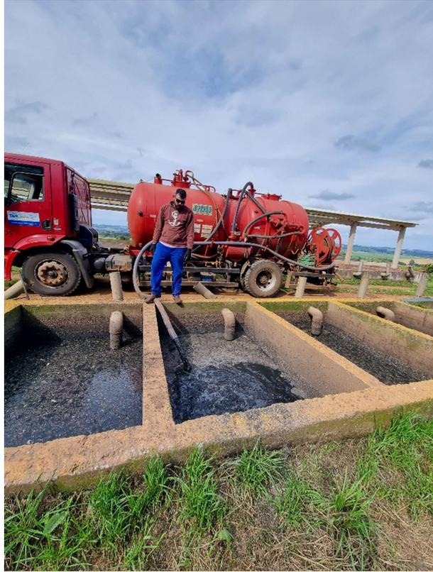
Figura 2: Descarga de lodo de tanques sépticos para posterior tratamiento
