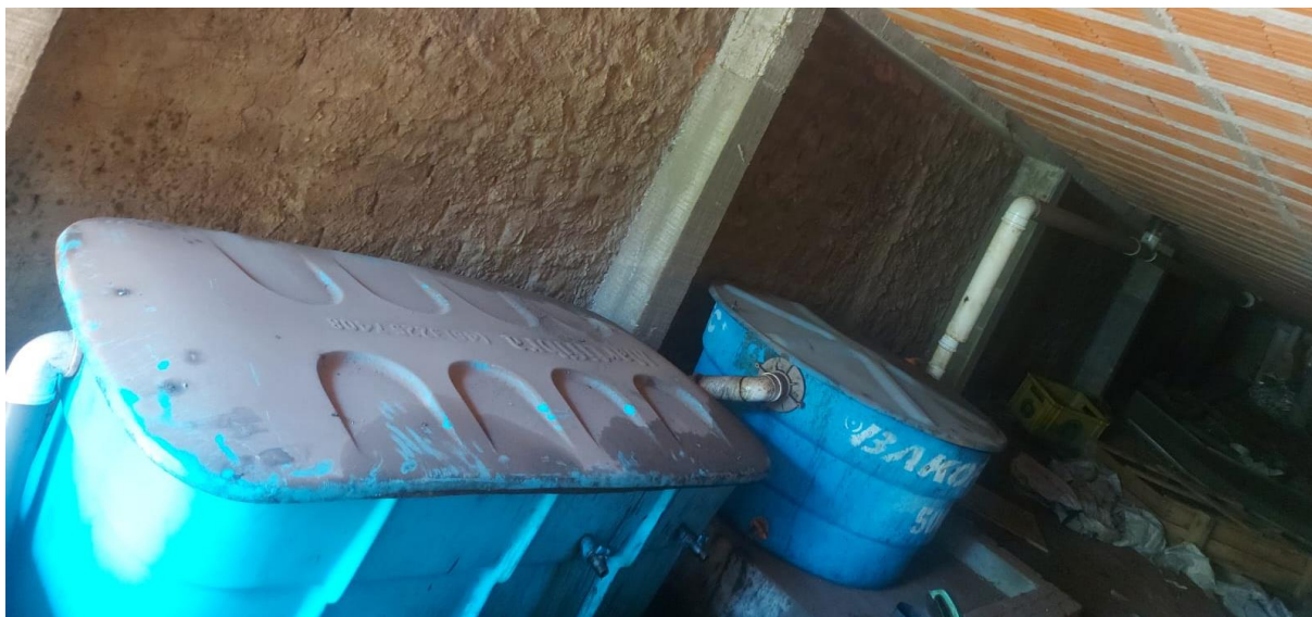
Figura 26 - Caixa separadora água e óleo (SAO)
