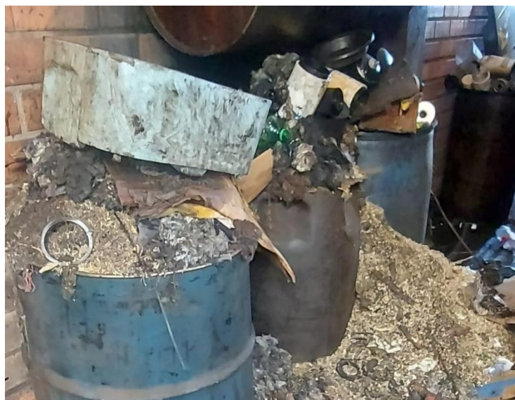
Figura 30 - Transbordo de material contaminado
