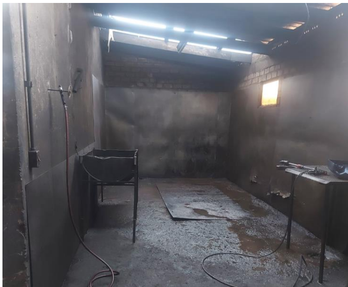
Figura 14 - Sala de lavagem
