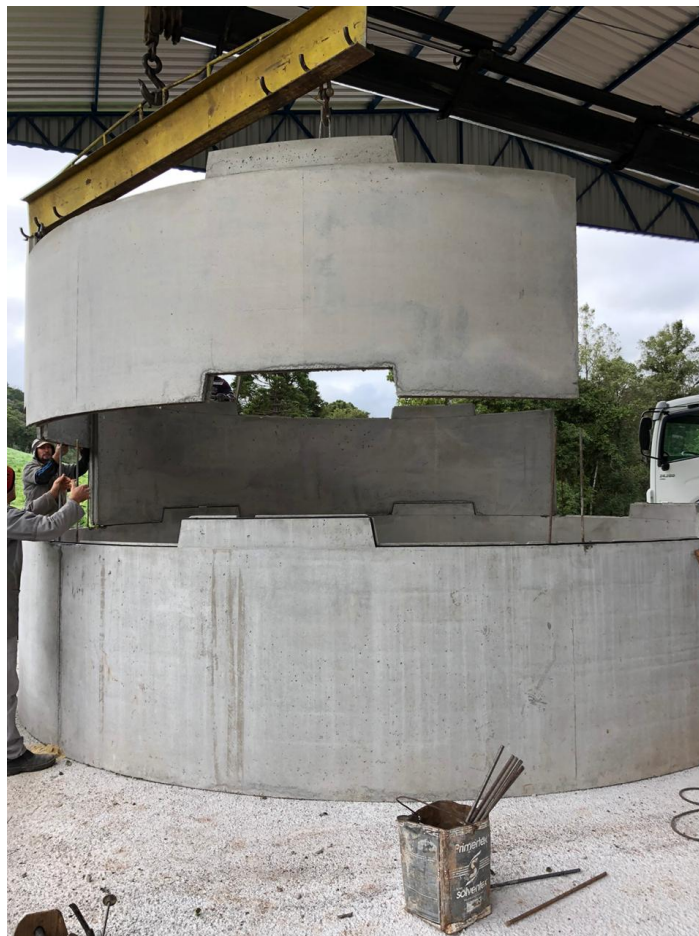
Figura 6 – Processo de montagem do silo
