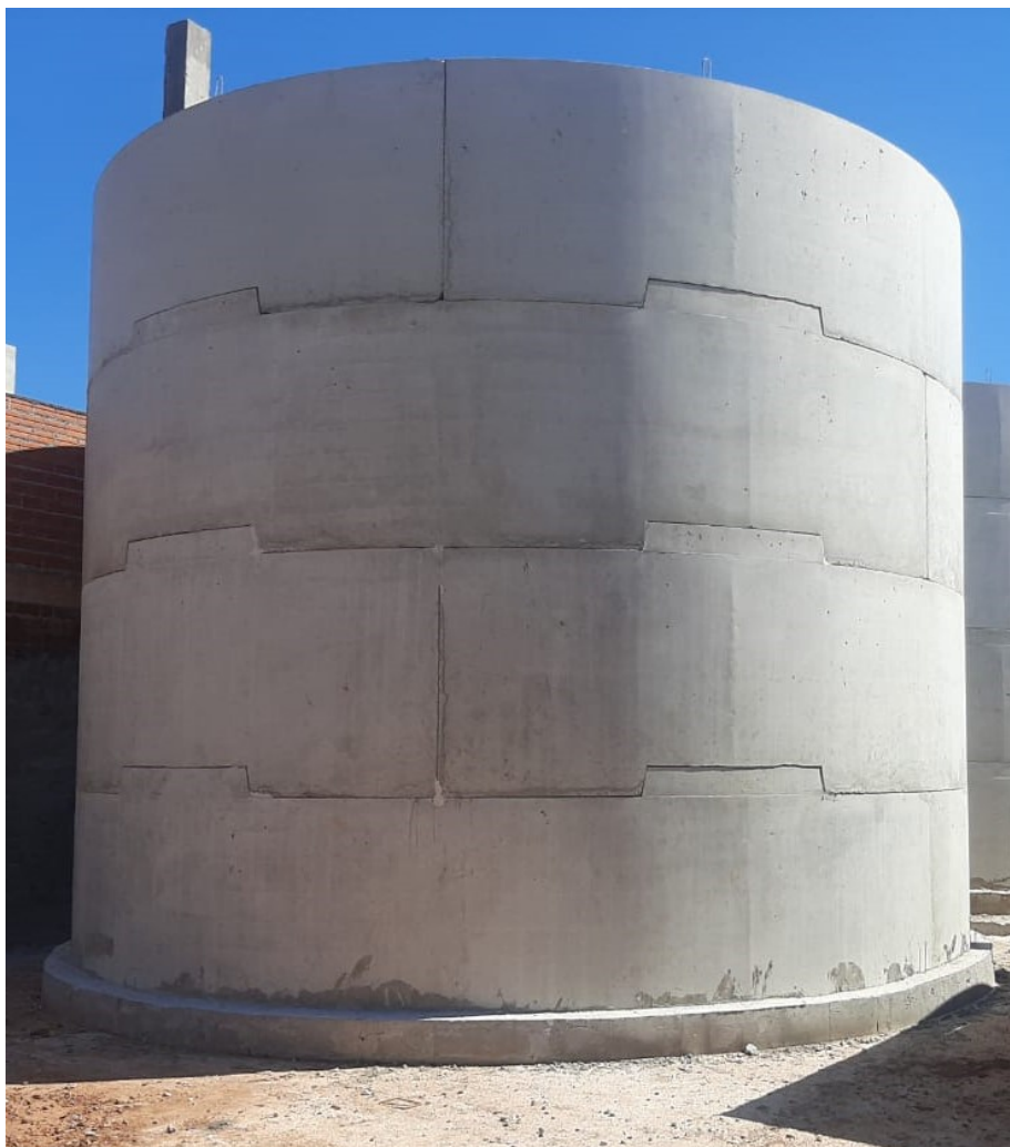
Figura 3 – Silo secador pré-fabricado de concreto
