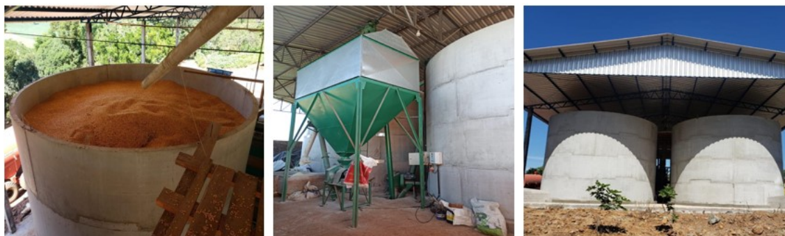
Figura 7 – Compilado de imagens do silo secador pré-fabricado de concreto
