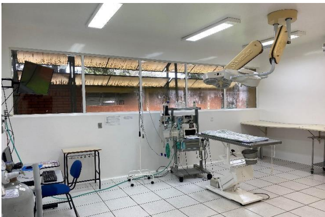
Figura 4 – Infraestrutura do Bloco Cirúrgico do HV-UPF – Sala para procedimentos cirúrgicos ortopédicos e neurológicos.
