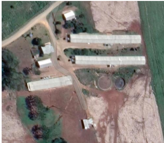
Figura 3 - Vista aérea da propriedade localizada na Linha Auxiliadora - Camargo. Propriedade conta com 3 galpões destinados para a fase de creche e 2 esterqueiras para despejar/armazenar os dejetos dos animais durante o tempo de alojamento e na hora de lavar os galpões. Fonte: Google Maps, 2023.
