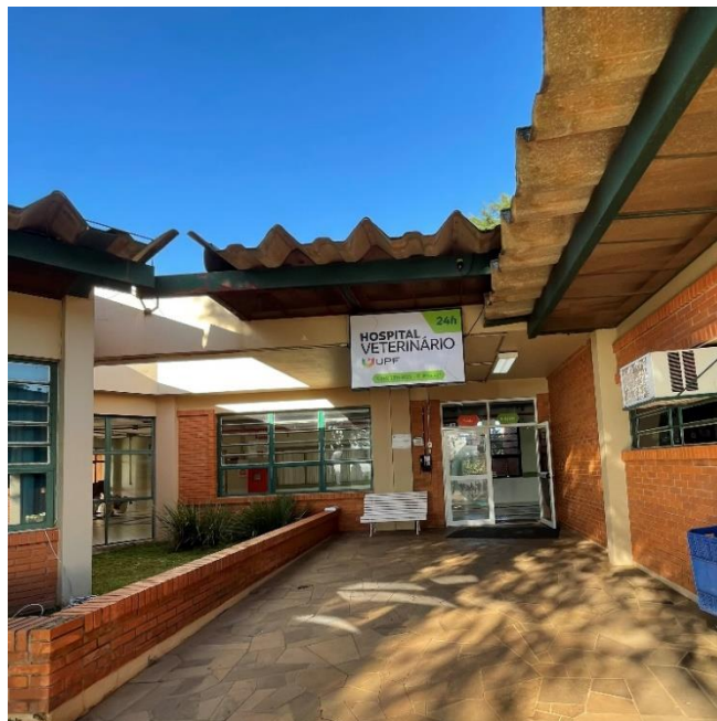
Figura 1 - Fachada do Hospital Veterinário da Universidade de Passo Fundo.
