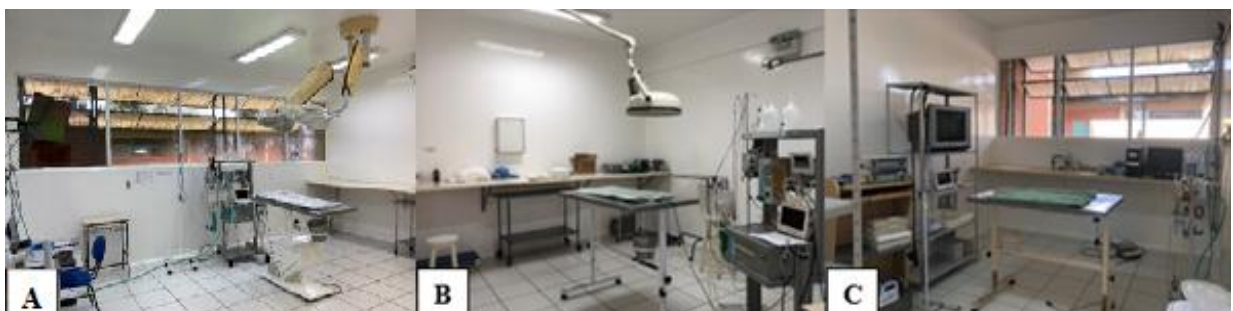
Figura 5 – HV- UPF, Passo Fundo. (A): Sala destinada para procedimentos complexos. (B): Sala destinada para procedimentos contaminados. (C): Sala destinada a procedimentos endoscópicos.
