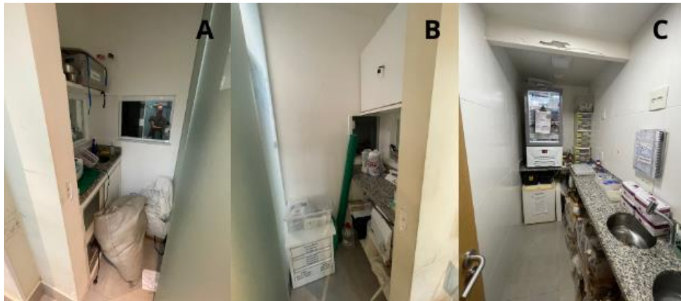
Figura 12. Clínica Doutor Silvestres. A) Expurgo. B) Esterilização. C) Laboratório.
