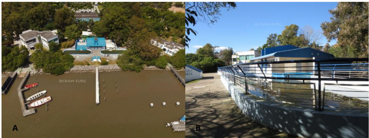
Figura 1. Centro de Recuperação de Animais Marinhos (CRAM). A) Vista por drone da área. B) Área de visitantes.
