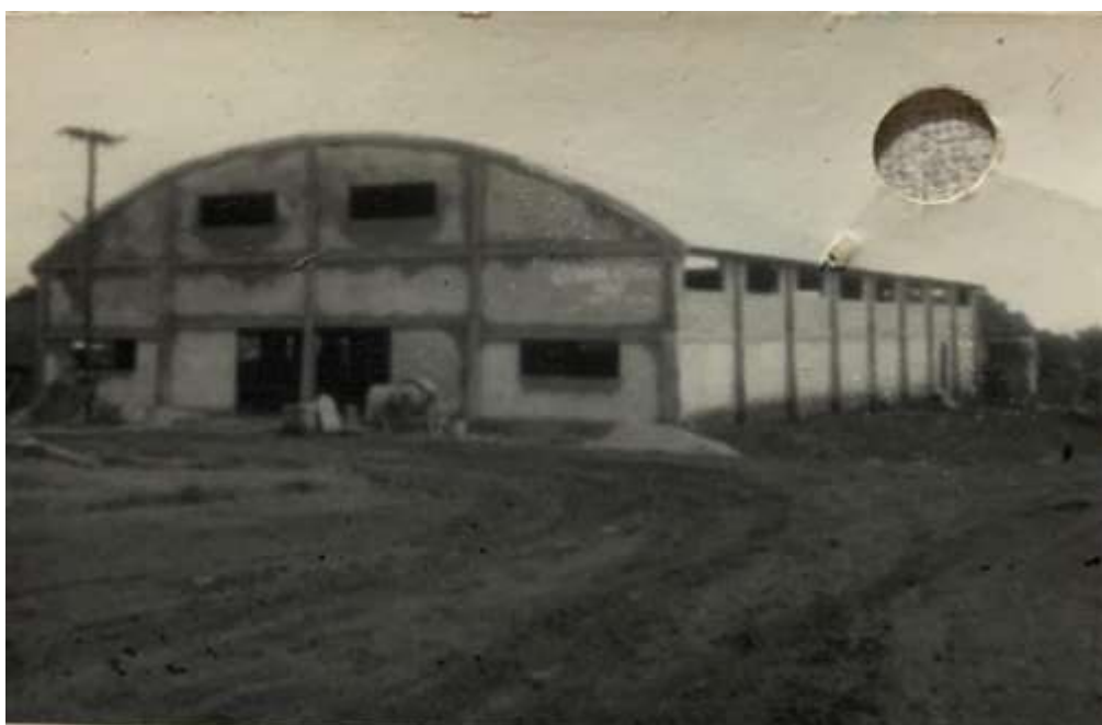
Figura 16 - Pavilhão Católico de Tesouras (1982)
