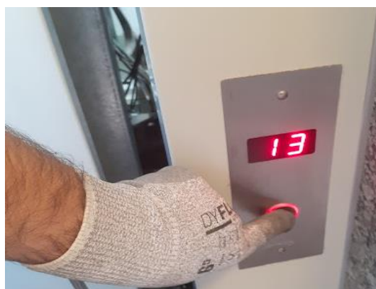
Figura 11: Efetuando uma chamada através do botão de pavimento.
