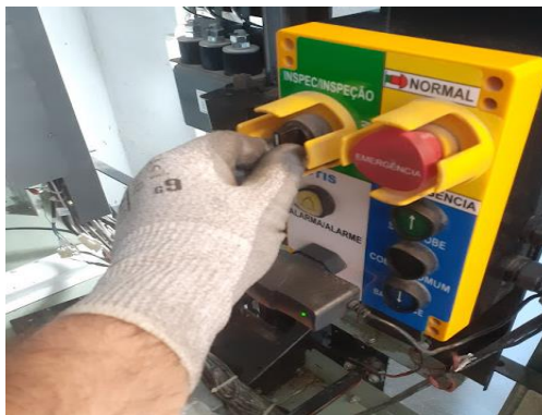
Figura 13: Ligando a chave de inspeção no topo da cabina.
