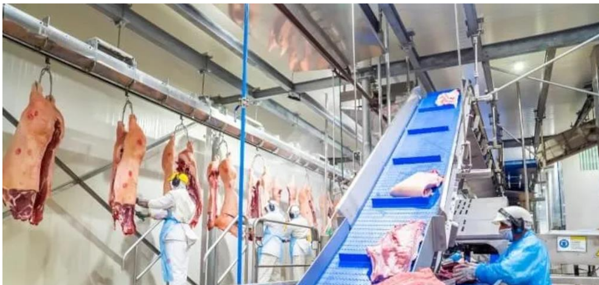
Figura 3 - Transportador aéreo sustentado em estrutura metálica em uma desossa de suínos.
