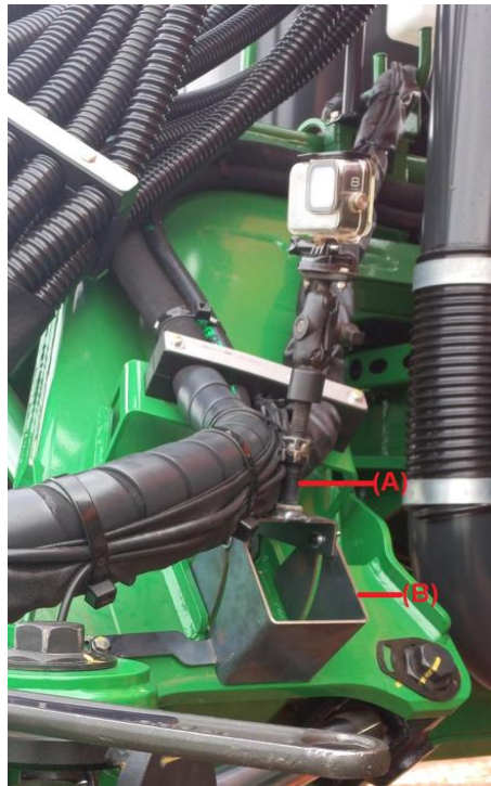
Figura 28 – Instalação do suporte da câmera fotográfica.
