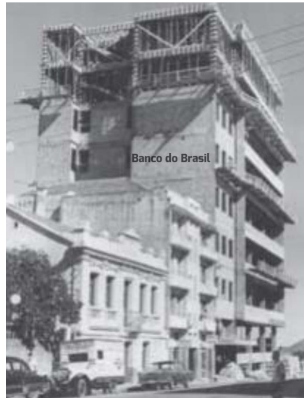
Figura 15- Edifício Banco do Brasil em construção.
