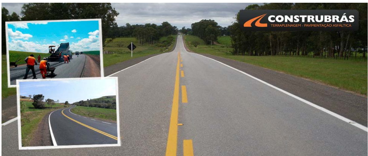
Figura 09: Pavimentação Asfáltica na Br 153 – Bagé a Aceguá. Fonte: Construbrás, 2013.
