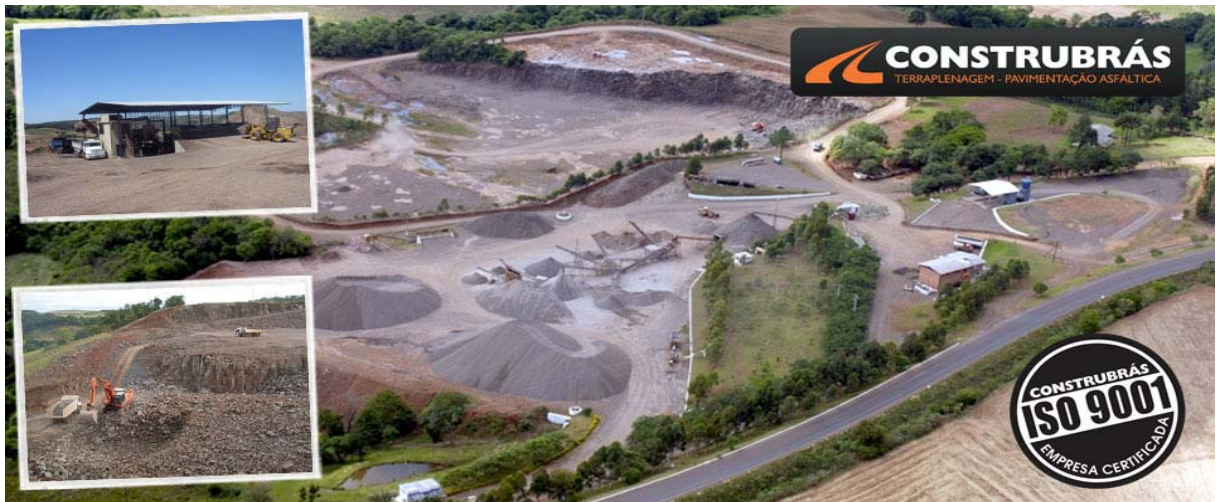
Figura 08: Unidade de Britagem na Rodovia RS 500, Sarandi – RS. Fonte: Construbrás, 2013.
