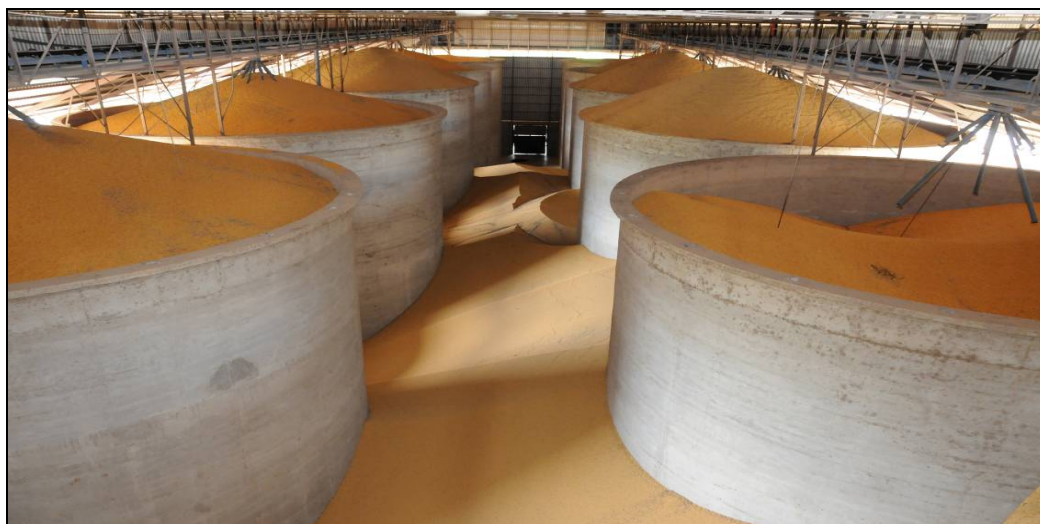
Figura 8 – Silos de armazenagem de grãos.
