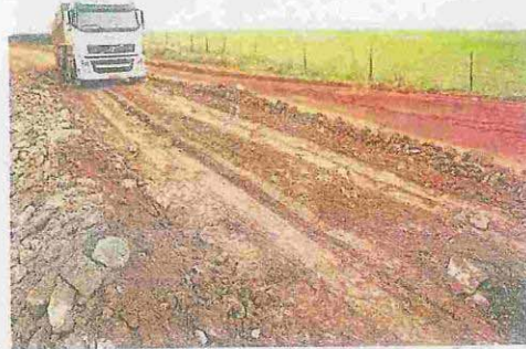
Cerca de 75% do volume de grãos colhidos no Estado é levado de caminhão até o porto de Rio Grande, apesar das péssimas condições das estradas
