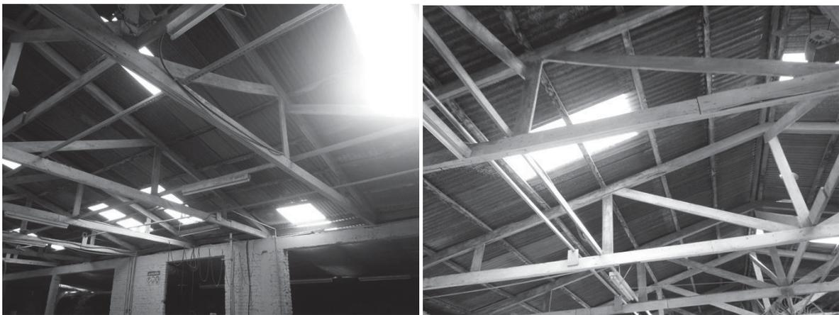
**Figura 18 - Telhado de acrílico**
