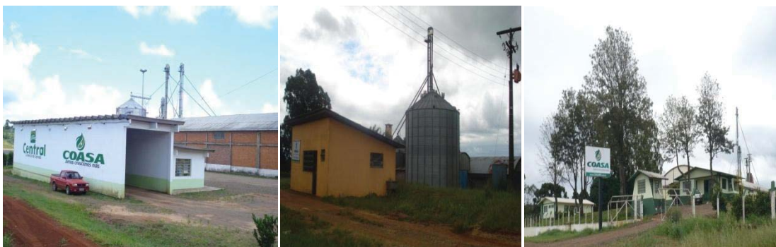
Figura 5: Silos de Ciríaco, Cruzaltinha e Caseiros-RS. Fonte: Cooperativa Agrícola Água Santa Ltda.
