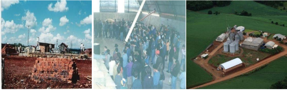
Figura 1: Construção, inauguração e instalações atuais do silo da Coasa em Água Santa-RS. Fonte: Cooperativa Agrícola Água Santa Ltda.
