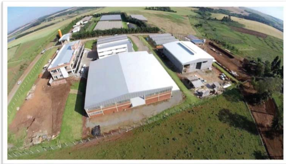
Figura 5. Construção da nova sede da Biotrigo, 10/2014.
