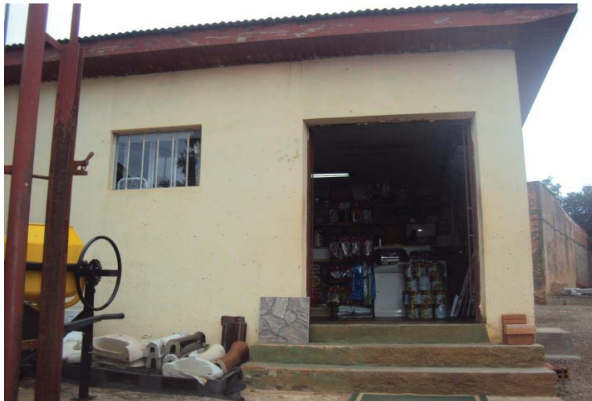
Figura 12 - Fachada frontal da loja
